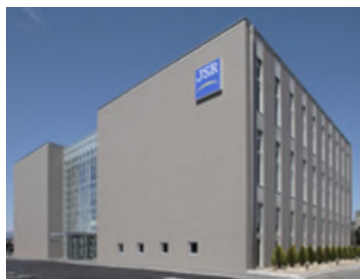
四日市地区研修センター
