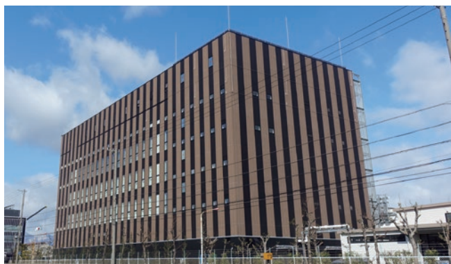
JSR新研究棟 (Center of Materials Innovation) の屋上にも「ハルeコート」が使用されています。
