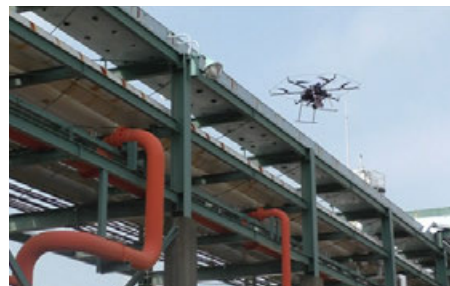
ドローンによる飛行点検
